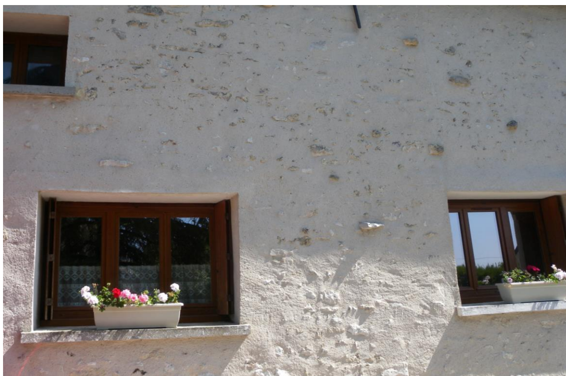
Photo 83: enduit à « pierre vue »
