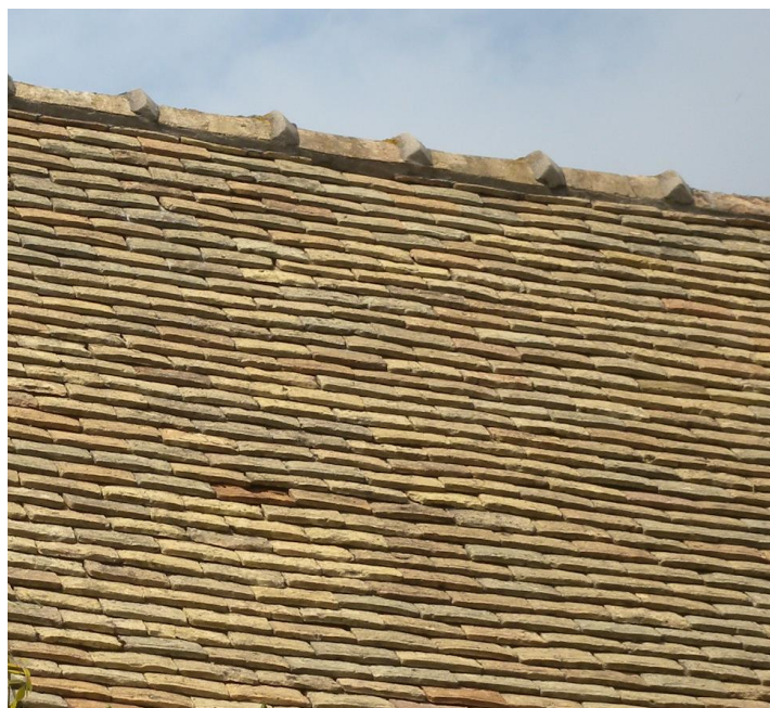
Photo 90 : exemple de toiture
