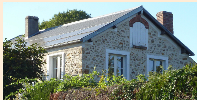
Exemple de disposition en bandeau et non saillante
