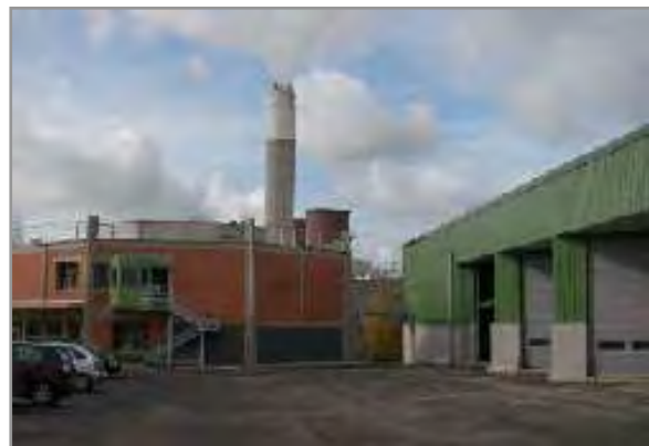
Centre de tri de Thiverval (Source : site Internet du SIDOMPE)
