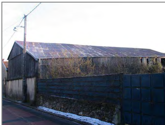
Hangar rue des Près aux Bois
