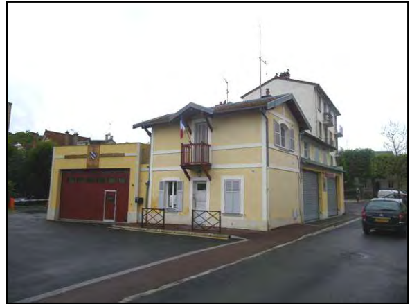
Caserne des Pompiers
