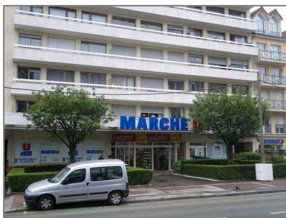
Commerce en rez-de-chaussée
