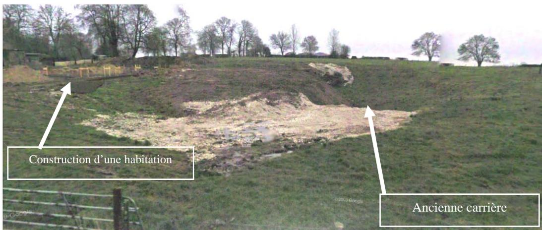
Figure 3-15 : Ancienne carrière en cours de remblaiement lors des travaux de construction de l'habitation (source google map – nov 2008)
