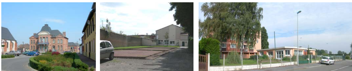
LE SECTEUR Ue REGROUPE DES PROGRAMMES, DES LIEUX ET DES EDIFICES AUSSI DIFFERENTS QUE LA MAIRIE, LE BOULODROME (JOUXTANT LA PARCELLE DU FUTUR ESPACE OXYGENE OU NOUVEL EQUIPEMENT) ET LA GENDARMERIE
