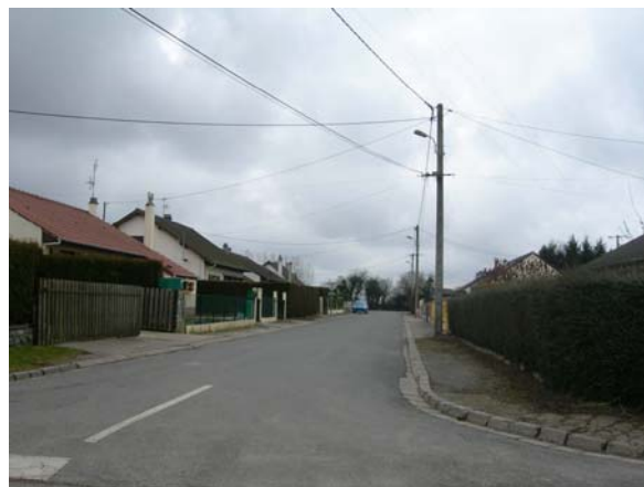
▲ LA RUE DU MOULIN EN ATTENTE D'UN RACCORD
