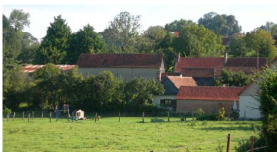
▲ A HOCQUINCOURT, UN CHEMIN TIRE LES GRANGES A LUI, EN PROFONDEUR DANS LE PARCELLAIRE. LE RELIEF NOUS REND APPARENT LE JEU DE TOITURE AINSI CREE.
