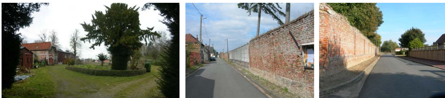
LES VISAGES DE L'ENCLOS DEPUIS L'ESPACE PUBLIC. DE GAUCHE A DROITE : L'ANGLE VISIBLE DEPUIS LA RUE DE LA REPUBLIQUE, LA FACADE RUE DES SIMONS ET CELLE DE LA RUE DES RAINVILLERS
