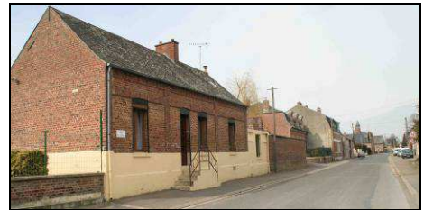
Tissu ancien de la rue de la Poste, HOMBLEUX : alignement en front de rue des façades.
