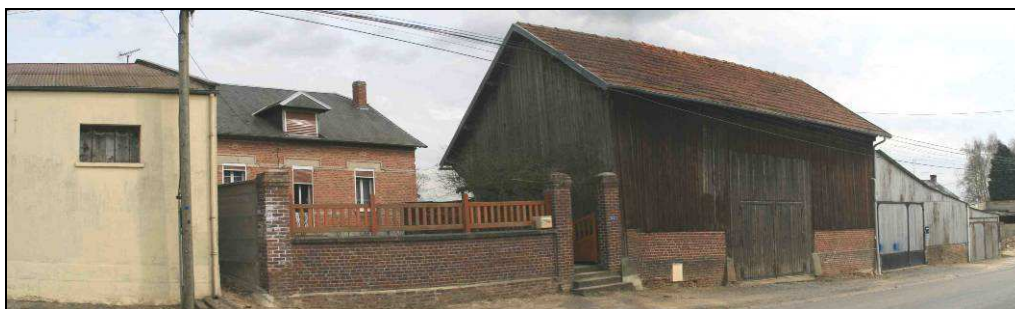
BACQUENCOURT : brique, enduit, bois et tôle.
