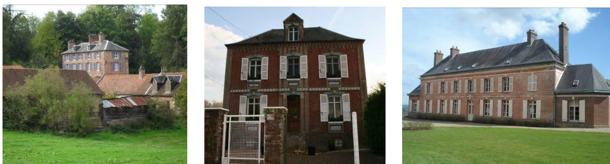
La Maison de Maître dans le corps de ferme près du bois de Caumondel remarquable par son volume et son ordonnancement, la maison bourgeoise et le château de VILLERS-SUR-MAREUIL (une attention toute particulière sera apportée aux sites recensés ainsi qu'à leurs abords immédiats)
