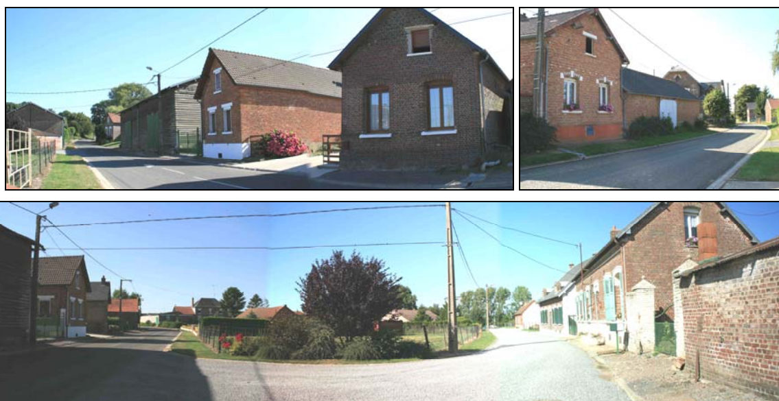
Echantillons du tissu ancien : rue de Lassu, rue des Vaches et rue de Derrière le choeur
