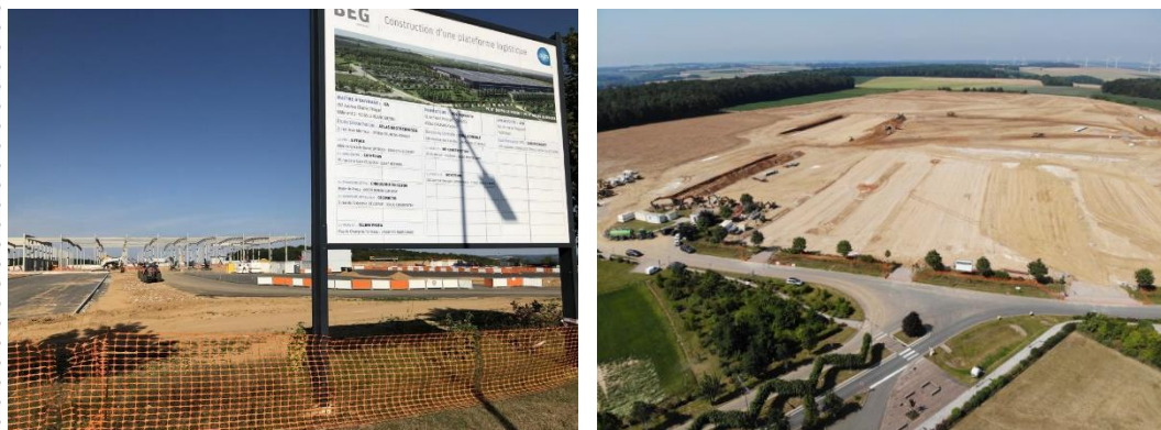
Chantier de construction de la phase 1
