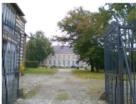
Entrée principale du château, côté centre
