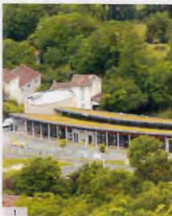
Le principe de ces structures consiste à recouvrir d'un substrat végétalisé un toit plat ou à faible pente (jusqu'à 30% maximum). Cette technique existe vraisemblablement depuis le néolithique. Aujourd'hui, les bénéfices apportés par les toits végétalisés en milieu urbain ne sont plus à démontrer. En plus de leur qualité esthétique, ces végétalisations répondent à un réel enjeu écologique et participent à l'amélioration du confort de vie des citoyens.
