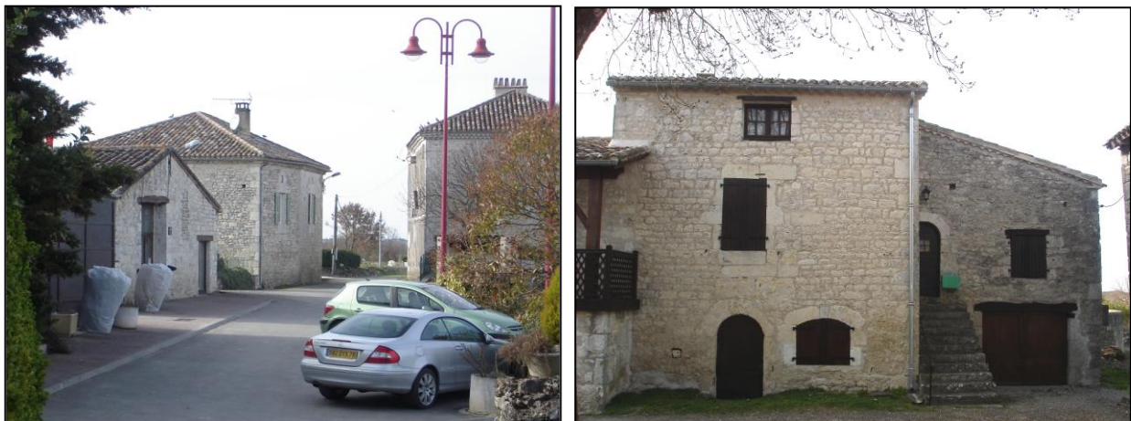
Bâti de caractère, revendicatif de l'identité quercynoise
