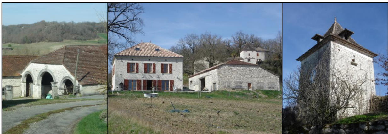
Bâti rural traditionnel
