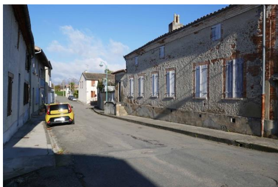
15 rue Teissié Soller
