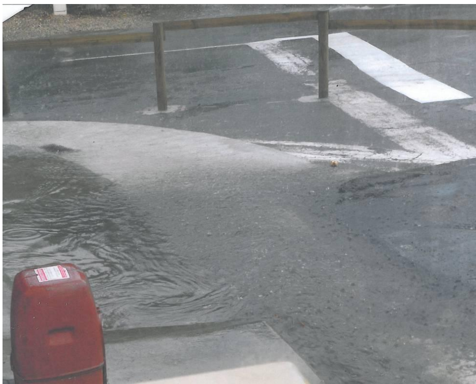
3 Place de Lafeuillade
