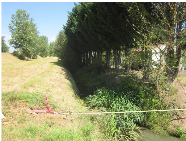
Exutoire du secteur Percin
