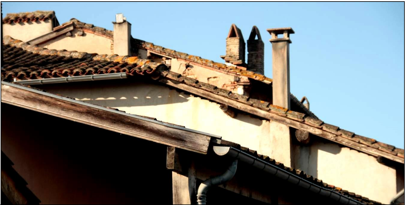
© ETEN Environnement 2009 Vue sur les toitures mitoyennes surplombant le chemin rural n°8 « Tour de Ronde »
