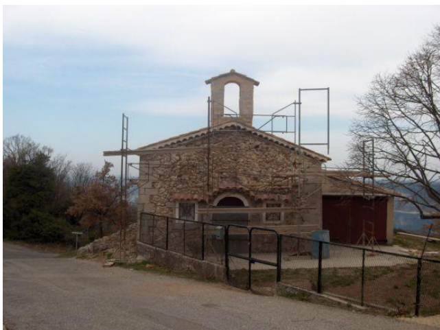
Chapelle à l'entrée de la zone NB
