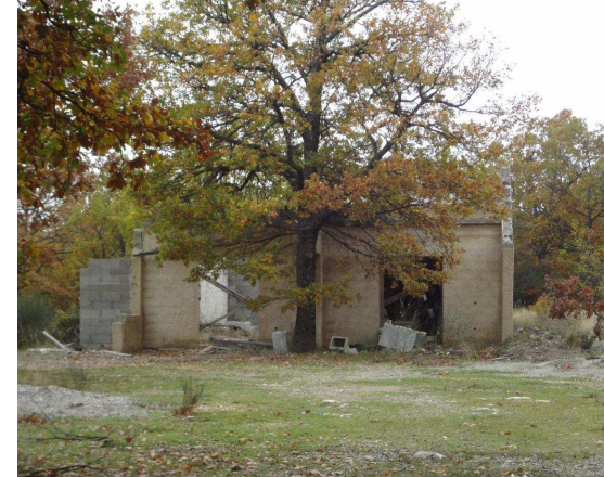
Bâti délabré en bordure de site
