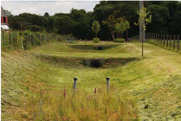
Exemple de bassin de rétention des eaux pluviales
