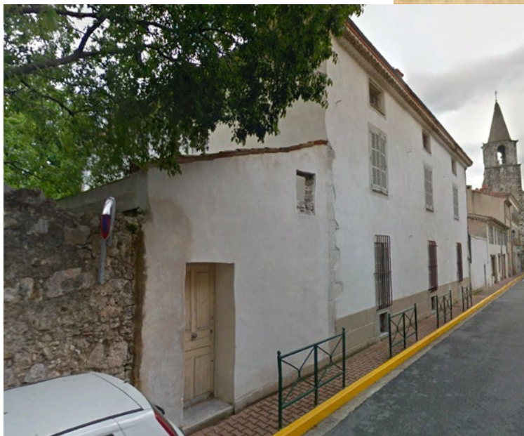
La façade Nord, rue Jean Jaurès.
