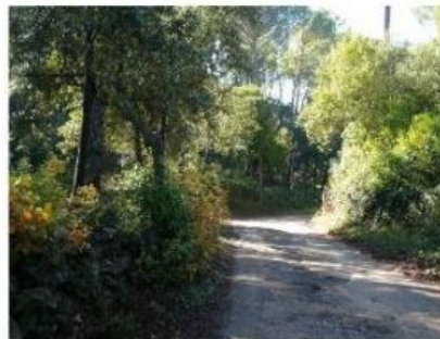
Chemin des Fourches Est
