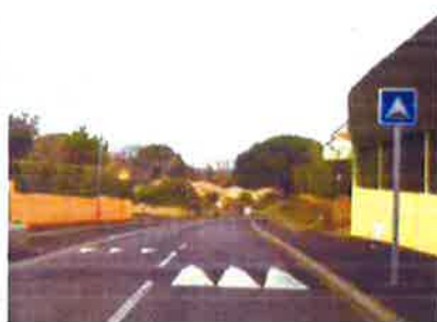
Illustration 6 : Dispositifs permettant de ralentir la vitesse des usagers en zone urbaine (coussin ralentisseur, « dos d'âne », chicane)
