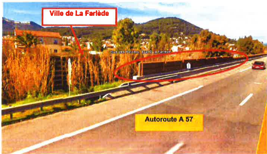
Illustration 9 : Mesure correctrice : écran acoustique devant un lotissement de La Farlède à partir de l'A57
