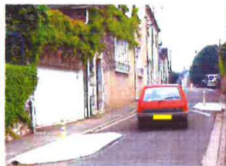
Illustration 6 : Dispositifs permettant de ralentir la vitesse des usagers en zone urbaine (coussin ralentisseur, « dos d'âne », chicane)
