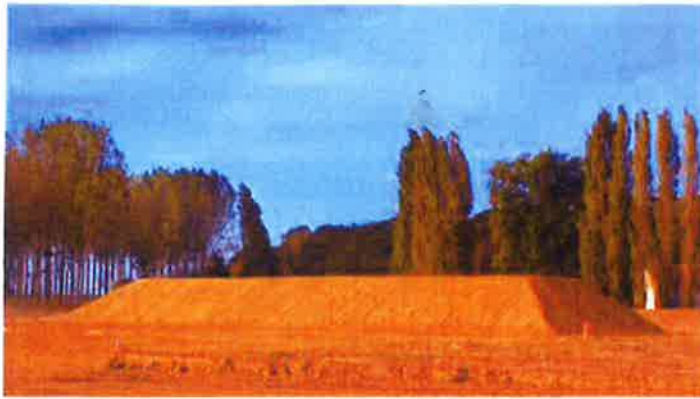
Illustration 8 : Mesure correctrice : merlon de terre devant des habitations
