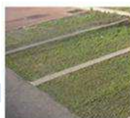
Parking enherbé avec ouvertures de drainage
