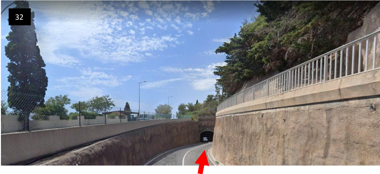
Entrée du tunnel Saint Clair
