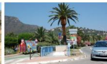
Passage piéton sous la RD 559 à Saint-Clair
