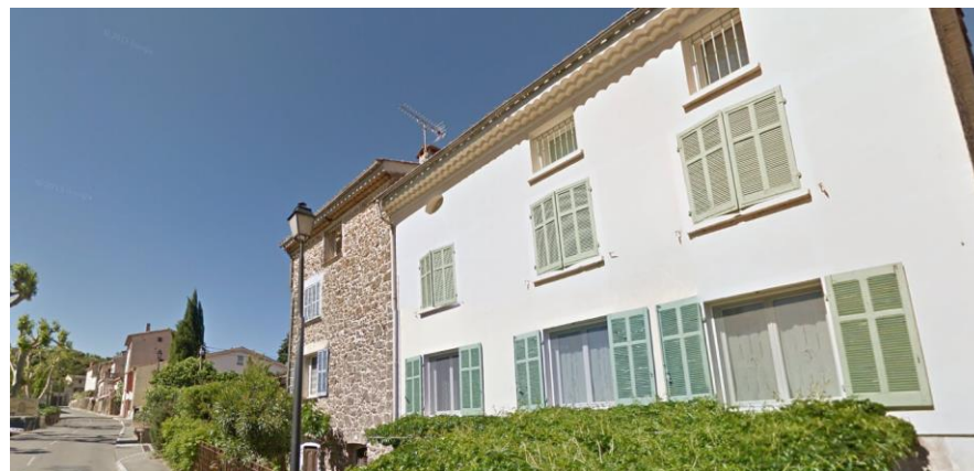
Boulevard André Bouis (source : Google Street View)
