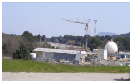
Usine de stockage de gaz STOGAZ
