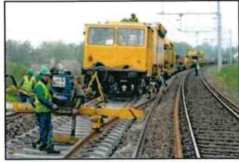
*Longs Rails soudés sur traverses béton*
