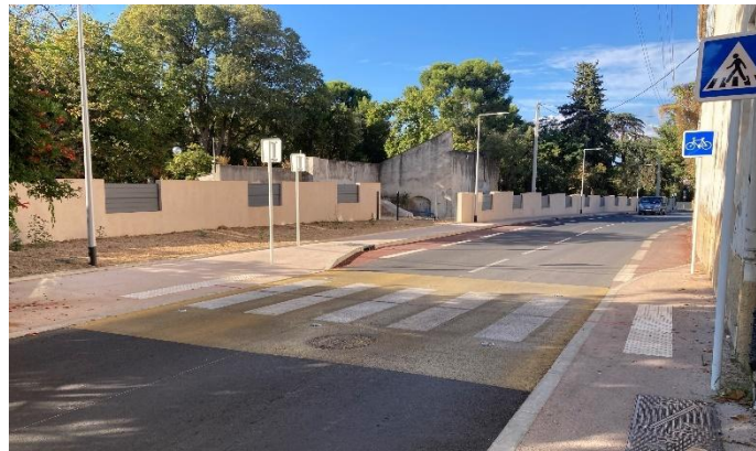
Avenue du Général de Gaulle (partie)
