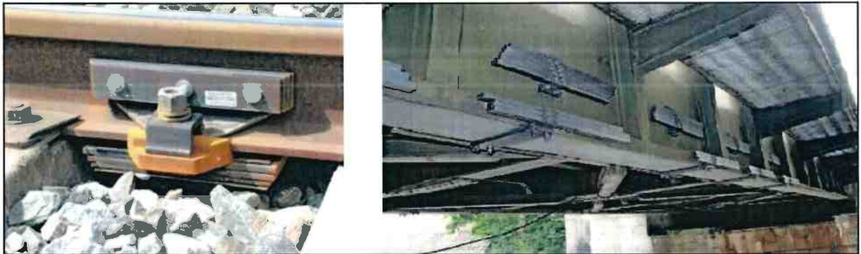
Exemples d'absorbeurs sur rail
