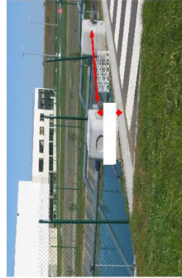
Plaque forme d'aspiration sur une réserve d'eau équipée de deux colonnes d'aspiration de 100 mm
