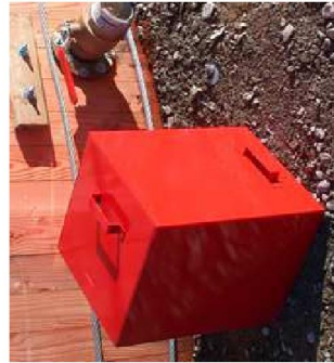
Prise directe de 100 mm sur réserve d'eau incendie aérienne
