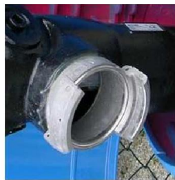
Poteau d'aspiration de 100 mm, muni d'une sortie de 100 mm, avec raccords fixe
