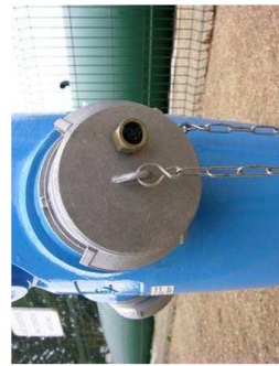
Poteau d'aspiration de 150 mm muni d'un Airclap
