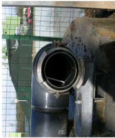
Une sortie de 100 mm avec les tenons verticaux (l'un au dessus de l'autre)
