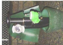
Intérieur d'une borne de puisage avec le raccord de 65 mm et compteur d'eau
