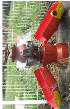
Poteau Incendie de 150 mm avec deux sorties de 100 mm et une sortie de 65 mm
