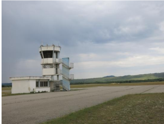
Figure 1 : Vue de la tour de contrôle située au sud-ouest de l'aérodrome
