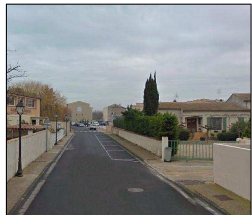
Route équipée de trottoirs vers le centre du village
