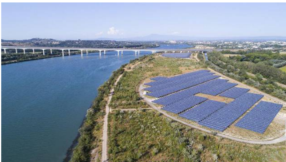
Parc photovoltaïque au sol – Quartier de la Courtine
