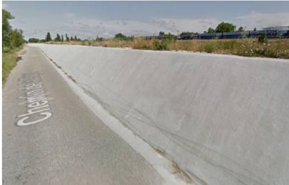
Digue le long de la Durance
