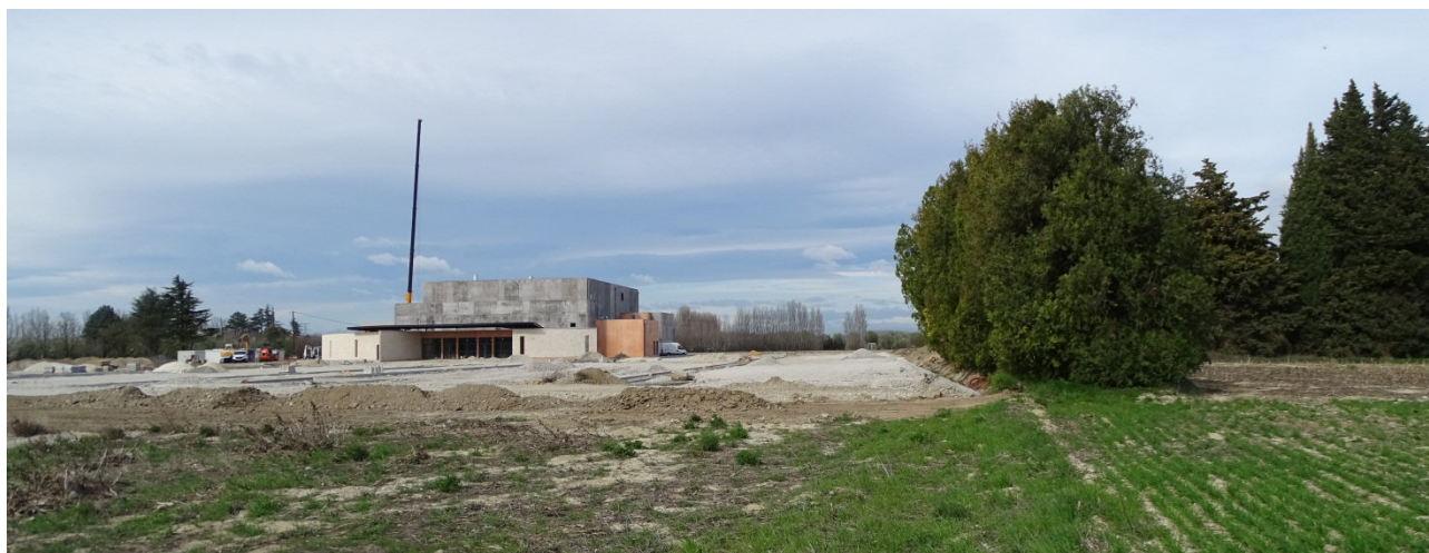
Travaux de la future salle des fêtes sur la parcelle limitrophe – vision limitée par la présence d'une haie, mars 2018
