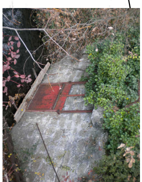
Vanne n°2: Tunnel
