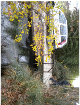
Vanne n°1: Rejet vers Aygues
