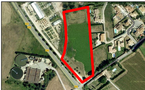
Zone naturelle d'expansion de crue, D43/station d'épuration
