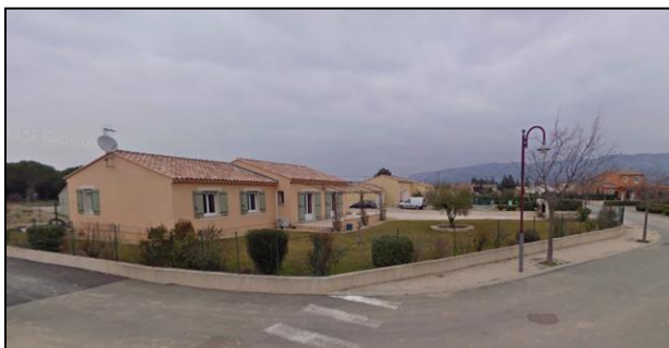
Lotissement chemin de Losque
