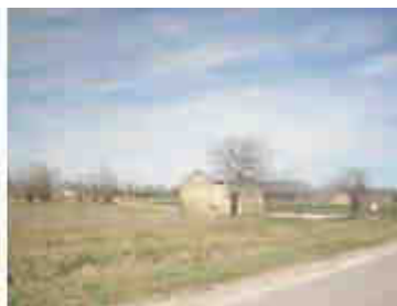
Cabanon agricole à l'abandon
