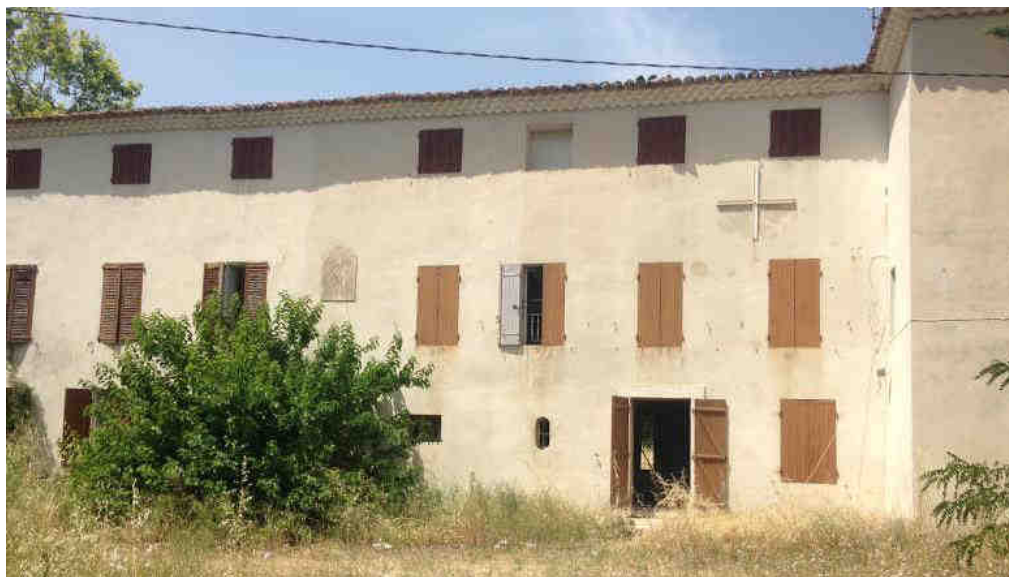
Corps principal avec ordonnancement classique des ouvertures
