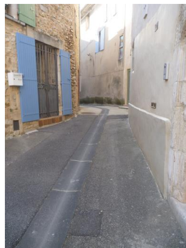
Figure 10 : Evacuation des eaux pluviales par ruissellement sur la chaussée
