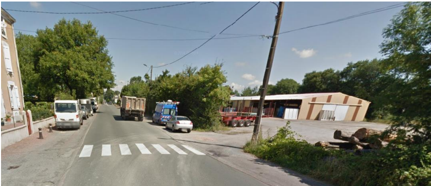
Le site de l'ex scierie Roturier
