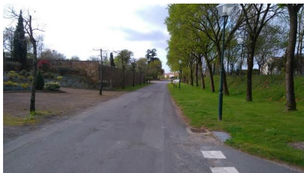
Figure 38 : grilles avaloir en entrée de bourg
