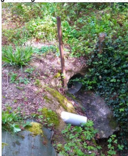
Figure 40 : Exutoire des eaux pluviales
