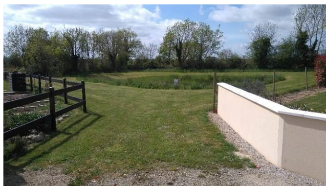
Figure 41 : Bassin pluvial du nouveau lotissement
