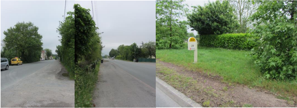
Les accotements de la RD938
