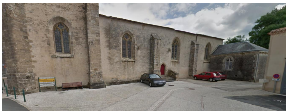
Le stationnement contre l'église
