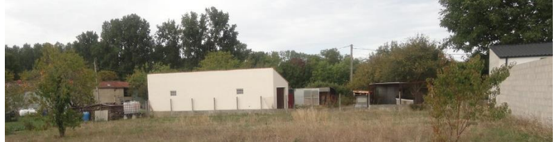
Impacts des murs proéminents dans ce paysage sensible de bord de marais.
