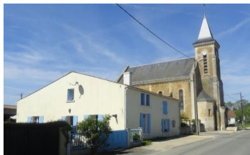
L'église construite à la fin du XIXème en frange du bourg.
