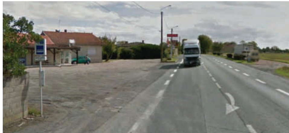
L'absence d'aménagement de sécurité pour traverser la route
