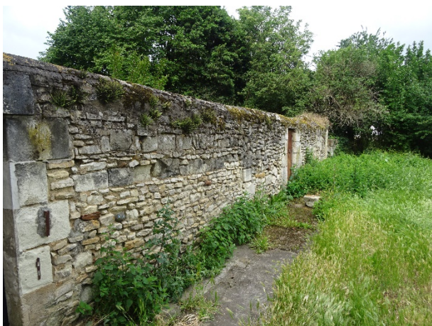
Moellonnages « assisés » destinés à être vus
