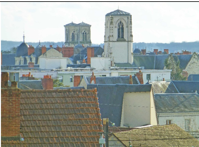
Trois types de couvertures présentes : une dominante d'ardoises, des tuiles plates (en bas à droite) et des tuiles à emboîtement « dites de Marseille ».
