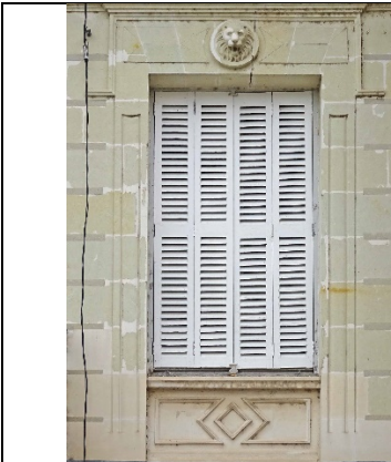
15-17 rue de Sully Le volet dépliant se développe au début du 20 ème siècle ; il évite de couvrir les encadrements de baies par des contrevents lorsqu'ils sont ouverts et sont rendus nécessaires par la présence des balcons.
