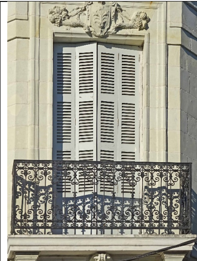
15-17 rue de Sully Le volet dépliant se développe au début du 20 ème siècle ; il évite de couvrir les encadrements de baies par des contrevents lorsqu'ils sont ouverts et sont rendus nécessaires par la présence des balcons.
