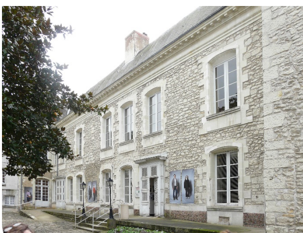
Façade moellonnée destinée à être enduite.
