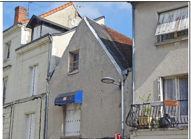
13 place Dupleix Les restes d'une couverture en tuiles plates, qui pourraient être celles de la couverture originelle.
