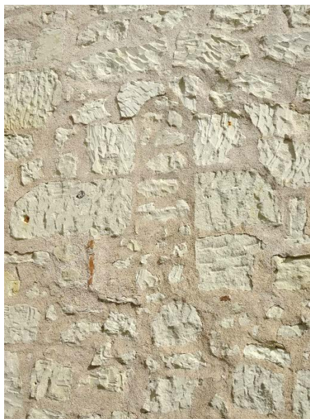
Façade « dépouillée » de l'enduit et archéologie du bâti
