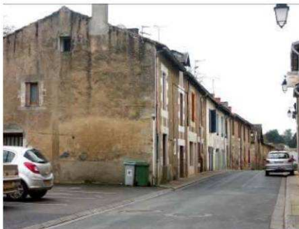
Alignement de maisons ouvrières Route d'Iteuil
