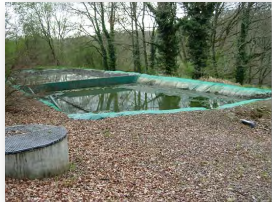
PHOTO 16 : STEP DE LA PLANCHE - BASSIN TAMPON
