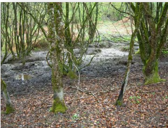
PHOTO 18 : ZONE DE REJET DES EAUX PLUVIALES DU CENTRE COMMERCIAL CARREFOUR
