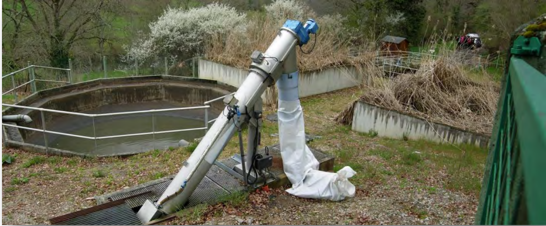
PHOTO 14 : STEP DE LA PLANCHE (VUE GENERALE)
