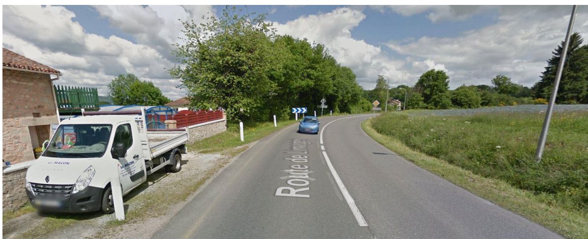
Vue de la RN 147 vers le Nord. La haie de haute strate se situe sur le devant du projet. (photo : google map)
