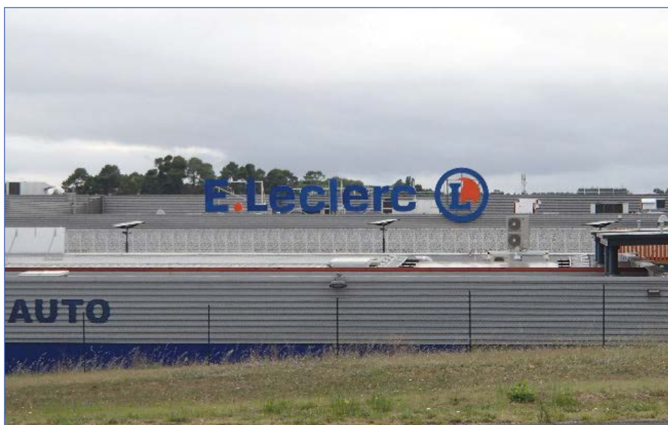
Enseigne en toiture (photo prise en dehors du territoire de Panazol pour illustration)
