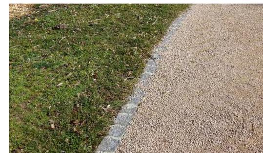
Exemple de revêtement perméable : chemin en stabilisé séparé des côtés enherbés par une rangée de pavés
