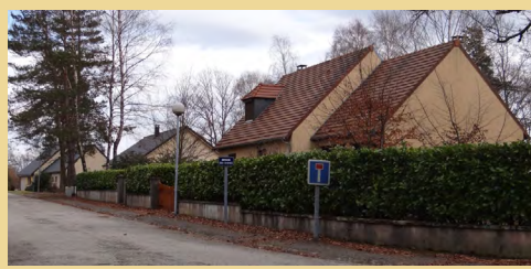
Auphelle lotissement : R et R+1 ou comble, bâti en retrait homogène du domaine public
