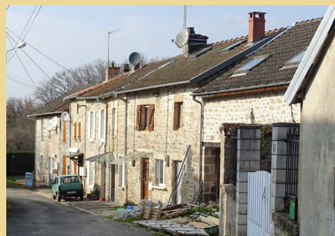
Faubourg du Breuil : R+1+combles, bâti aligné sur le domaine public
