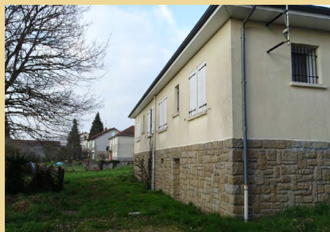
Cité des Tuileries : R et R+1, bâti en retrait homogène du domaine public
