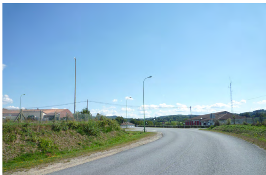
Déviations des années 90 par Lascoux : vue sur l'arrière du supermarché et la caserne des pompiers
