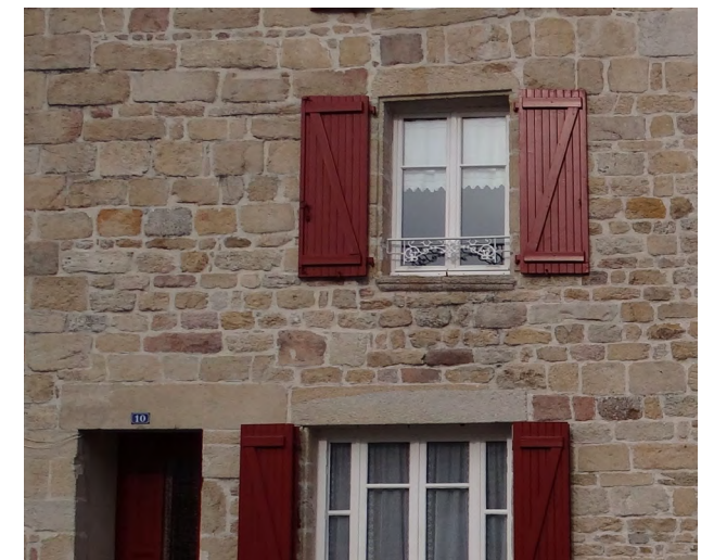
Utilisation du granite pour les linteaux et les moellons, les liants étant à base d'arènes.
