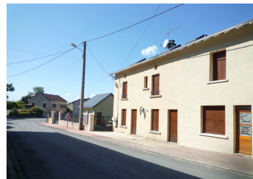
Maison de faubourg banalisée en pavillon
