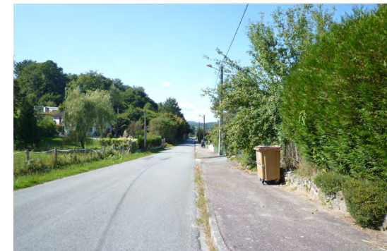
Route de Vassivière aux abords du lotissement du Breuil
