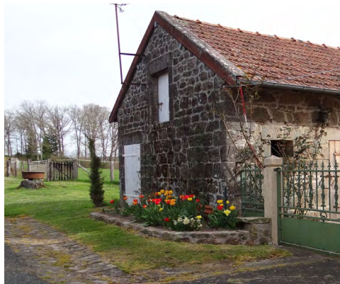
Mise en valeur de l'espace entre domaine public et privé, conservation du caniveau en pavés
