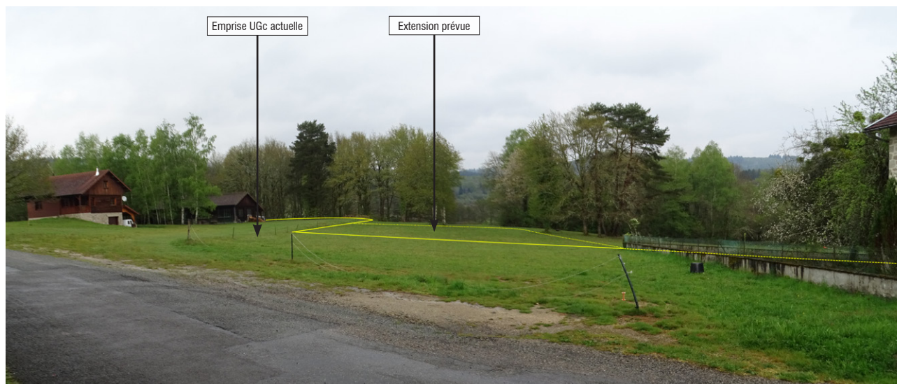
Vue générale sur le site du projet depuis la voie d'accès.
