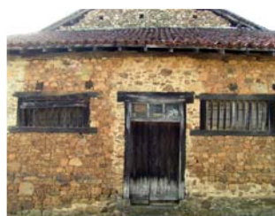
Restauration partielle d'enduit - Royères
