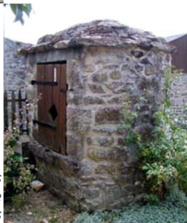
Couverture de puits en lauze Doms et Eymoutiers
