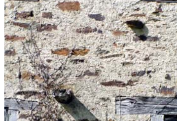
Maçonnerie à pierres vues - La Geneytouse
