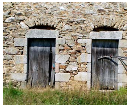
Linteaux surmontés d'arcs de décharge cintrés
