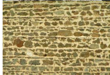
Enduit à pierres vues avec joints délinés
