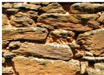
Maçonnerie hourdée à la terre - Linards
