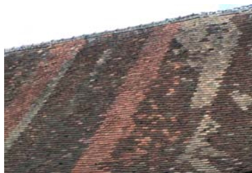
Toit en tuile plate Châteauneuf-la-Forêt
