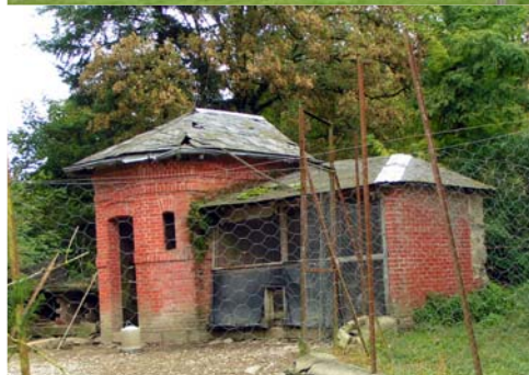
Construction en brique Bujaleuf
