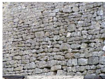
Maçonnerie de pierre sèche Sauviat-sur-Vige
