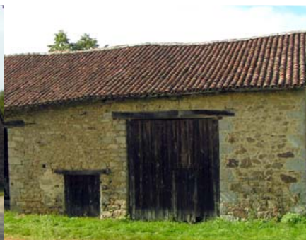
Toit en tuiles canal - La Geneytouse
