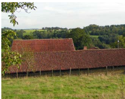
Toit en tuiles canal - Royères
