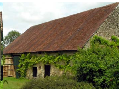
Toit en tuiles plates - Masléon
