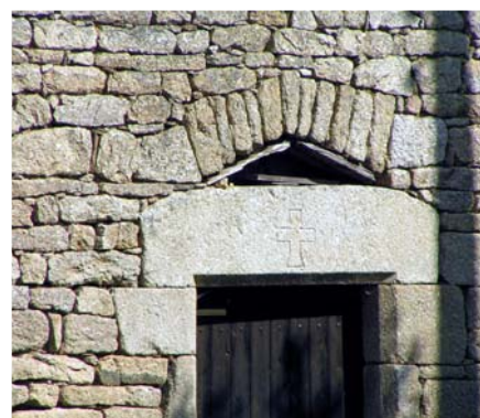
Linteau surmonté d'arc de décharge triangulaire
