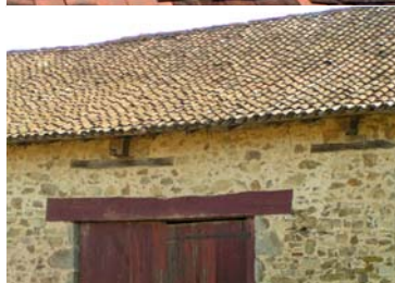
Toit en tuile creuse Royères
