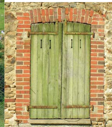
Encadrement de baie en brique Le Châtenet-en-Dognon
