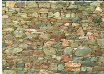
Moellons de schiste et gneiss Linards
