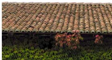
Toit en tuile creuse Champnétery
