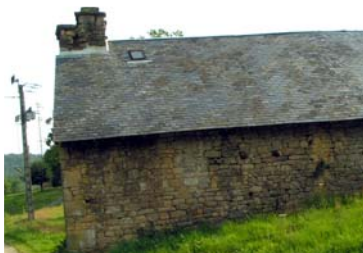
Toit en ardoise Eymoutiers
