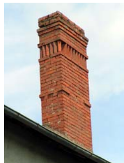
Souche de cheminée en brique Roziers-Saint-Georges
