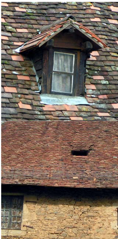
Lucarne-fenêtre en bâtière Roziers-Saint-Georges
