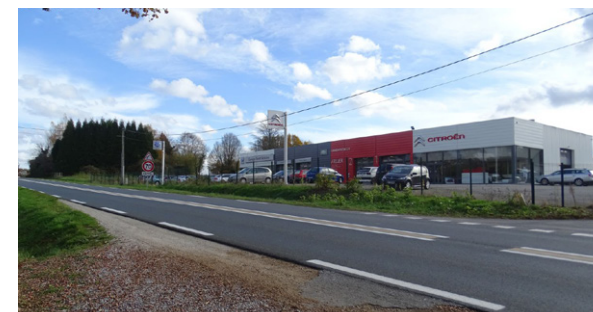
Bâtiments de type «boîte à chaussures» le long de la RD 941
