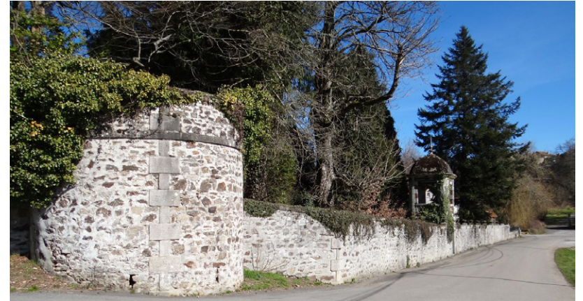
Gloriette et mur d'enceinte
