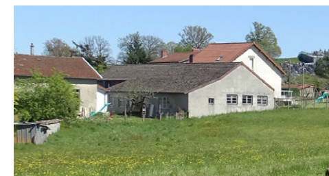
Bâtiment d'activité susceptible d'être démolí pour créer un deuxième accès
