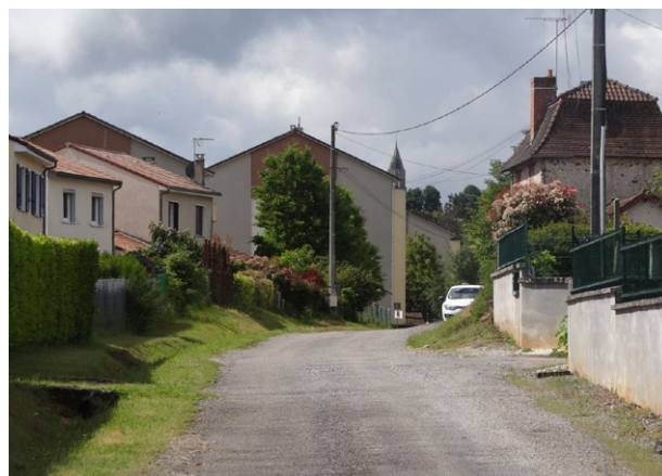
Vue sur la collégiale depuis le chemin de la Grande Ecurie
