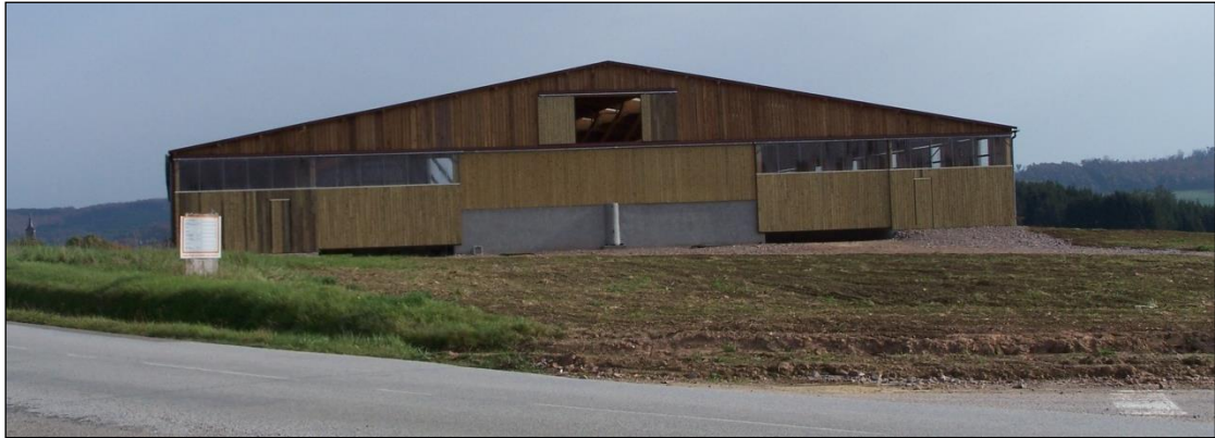
Bâtiment agricole entre LA BAFFE et MOSSOUX
