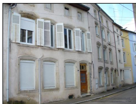
Habitations, rue de Rozelieures.
