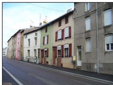
Alignement de façade le long de la rue Maurice Barrès.
